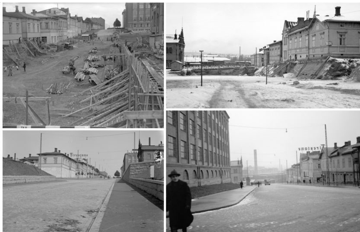
Kuvia Puolimatkatkadulta (Itsenäisyydenkadulta) vuosilta 1933 ja 1936. Ylemmissä kuvissa näkyy, miten kadun tasausta laskettiin tunnelin rakentamisen aikana. Alemmissä kuvissa töiden valmistumisen jälkeinen tilanne. (Lähde: Tampereen museot, Siiri-tietopalvelu. Kuvat Veikko Kanninen, Teuvo Mäkinen ja K-O.Lumme.).
